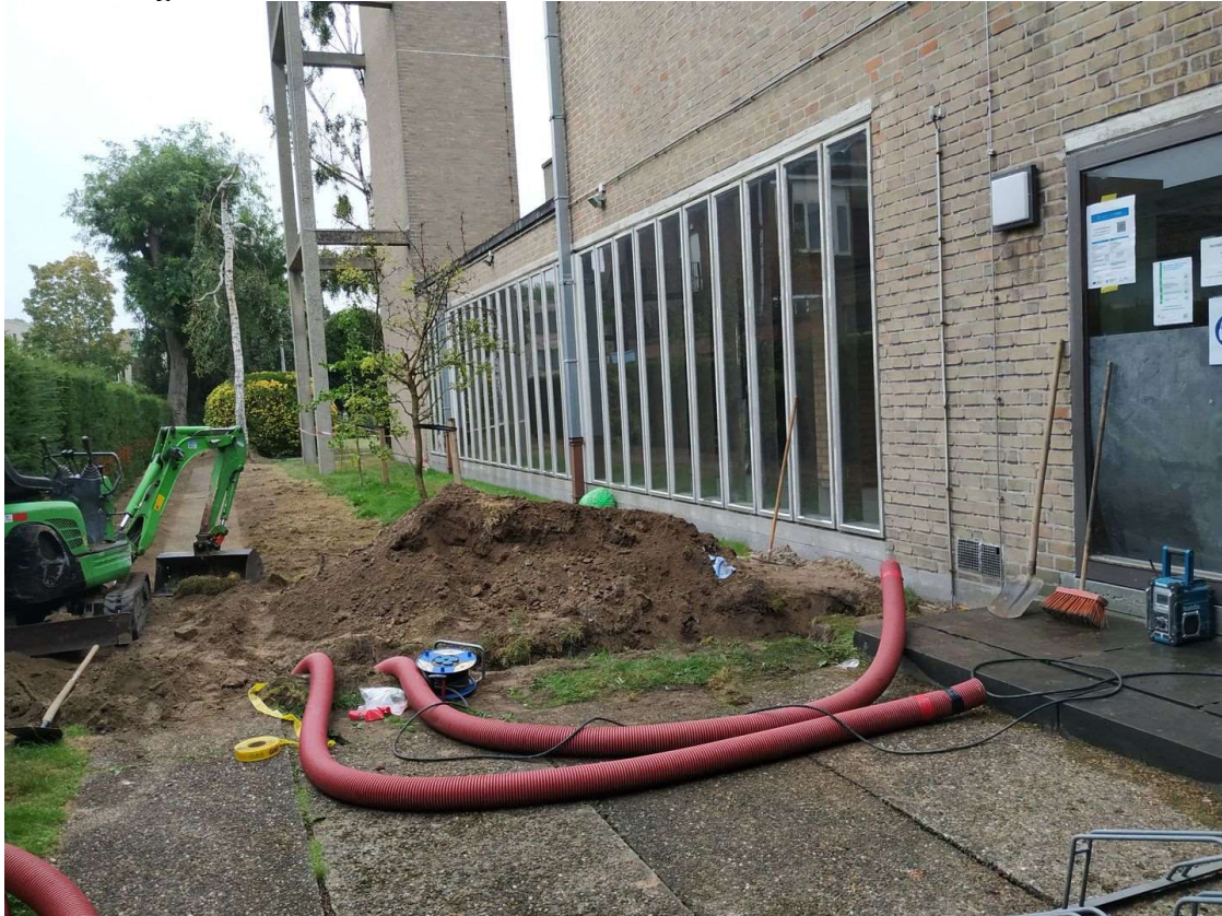
Op deze recente foto is te zien dat de sleuf ondertussen grotendeels is opgevuld. Het laatste stuk aan de zijingang van de kerk is nog open.
